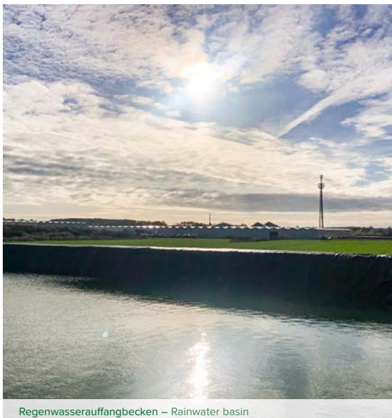
Regenwasserauffangbecken – Rainwater basin
